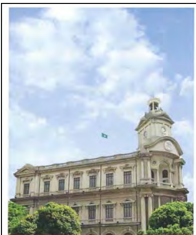
澳門郵電總部大樓 Edifício Sede dos Correios e Telecomunicações de Macau Macao Post and Telecommunications Bureau Headquarters' Building
